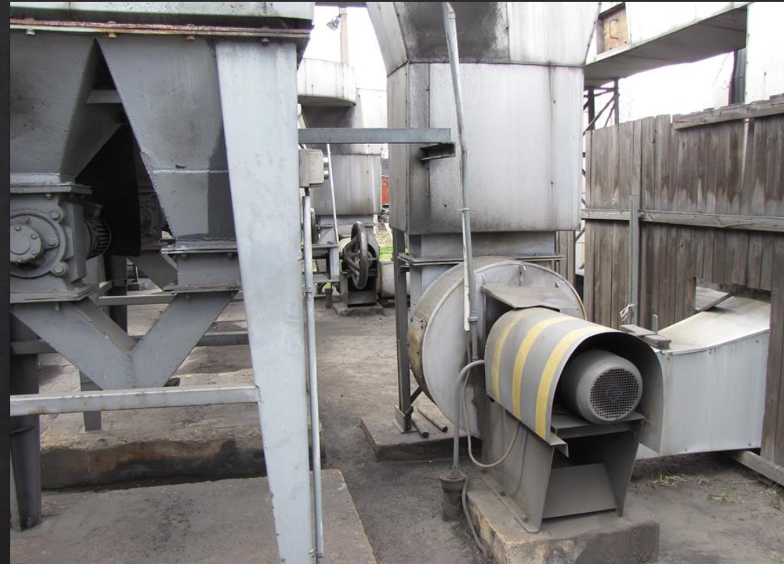
Rys. 26 Szczegóły budowy odpylacza. Fotografia własna- kwiecień 2021r.
