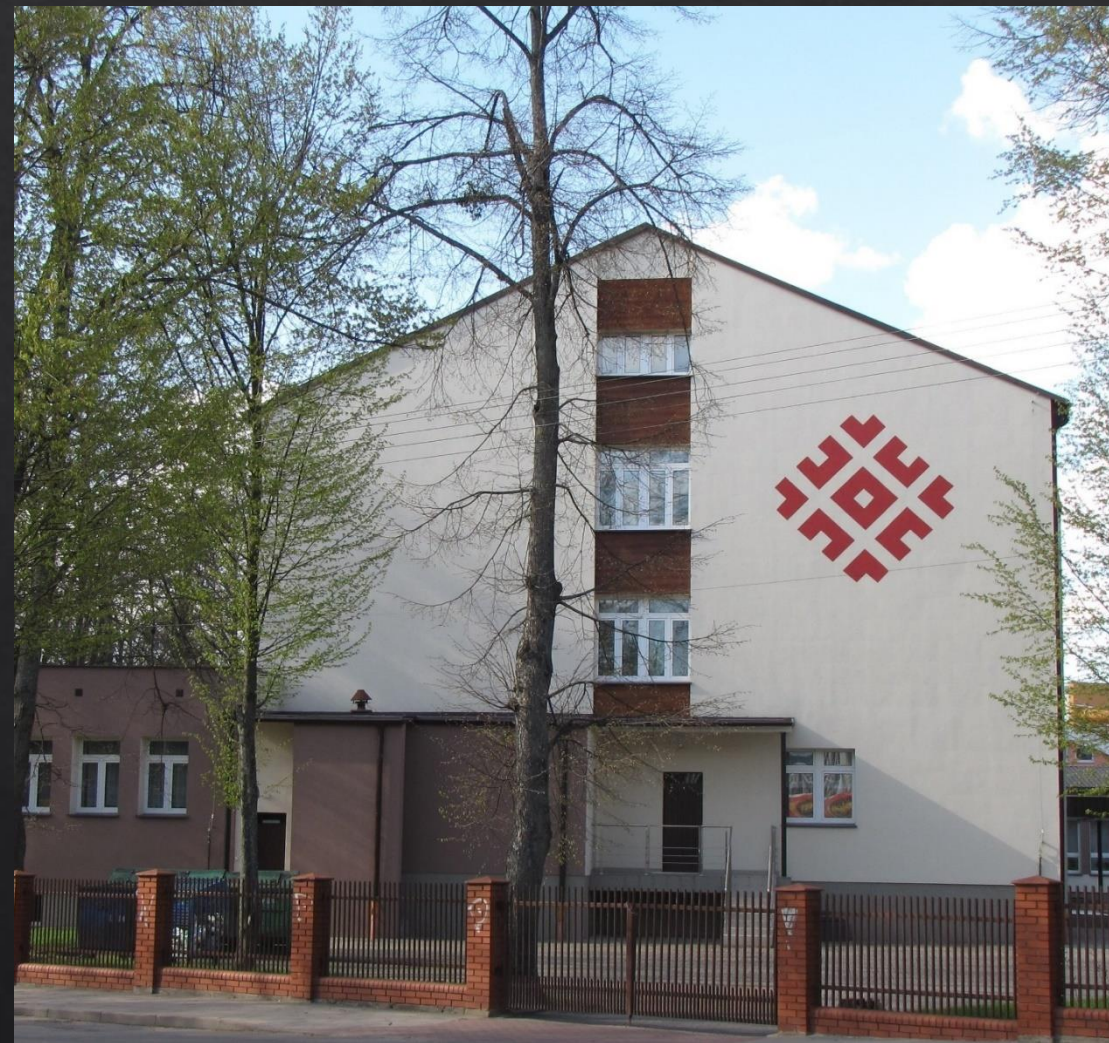
Rys. 23 Budynek II LO z DNJB w Hajnówce po termomodernizacji. Fotografia własna- maj 2021r.
