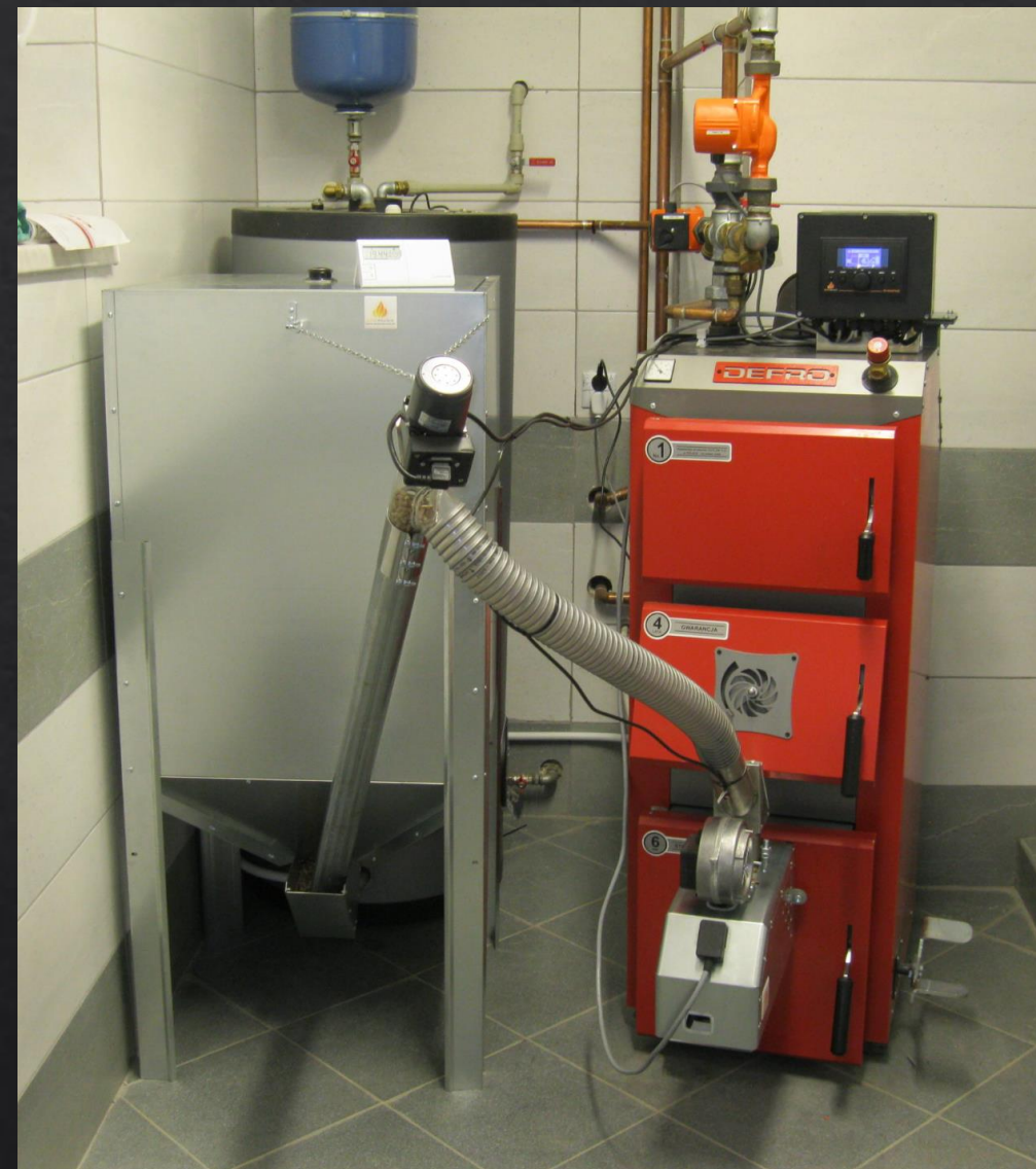
Rys. 39 Zdjęcie kotła 5 klasy z domontowanym palnikiem na pellet; https://eco-palnik.pl
