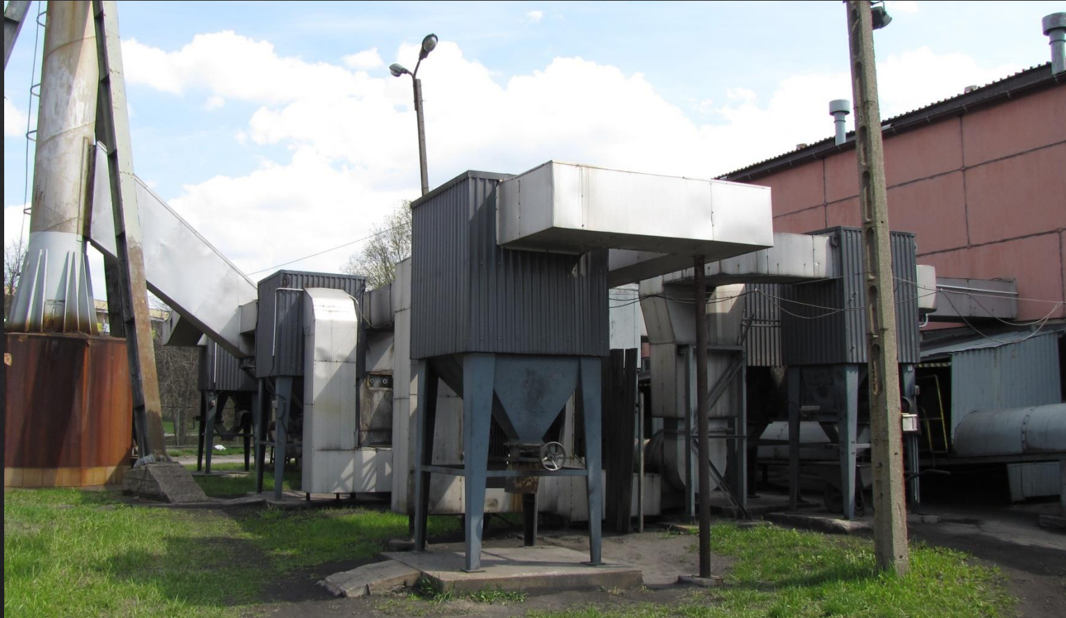
Rys. 24 Odpylacze z serii NGK w ciepłowni PEC. Fotografia własna kwiecień 2021r.
